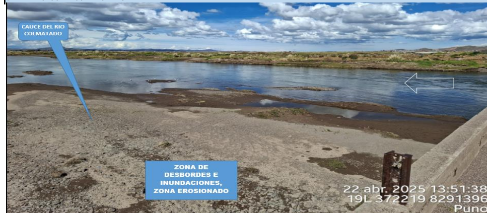
FIGURA 1 y 2: TRAMO CRÍTICO EN EL RÍO CABANILLAS, EN EL SECTOR HUICHAY JARAN, DISTRITO DE JULIACA, PROVINCIA DE SAN ROMÁN - PUNO. NOTESE, LA ACUMULACIÓN DE MATERIAL SEDIMENTADO EN EL CAUCE, QUE REQUIERE SER ELIMINADO PARA REESTABLECER LA SECCIÓN HIDRÁULICA DE LA CAJA DEL CAUCE EN ESTE SECTOR.
